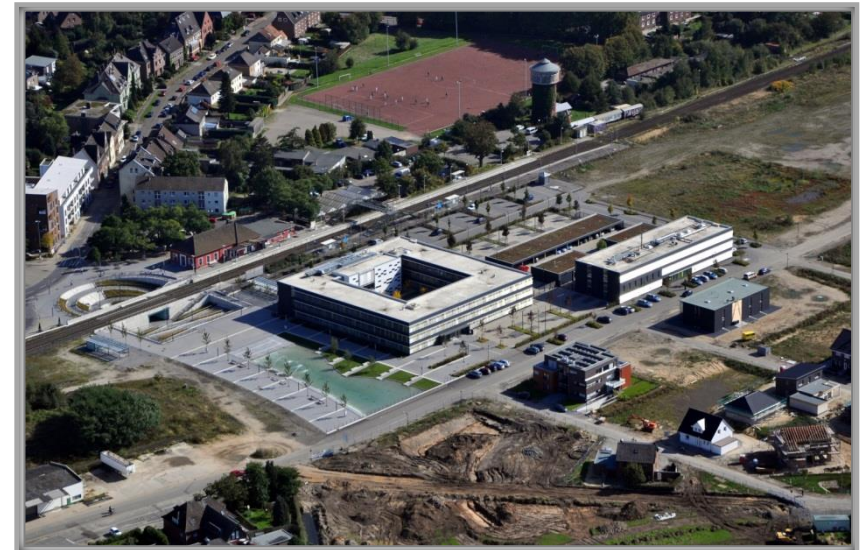
Bauphase des Finanzamtes, Hintergrund: EG, Vordergrund: Neues Wohnbaugebiet
