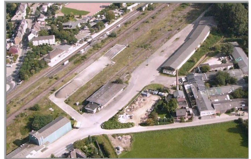
Vorher: Gelände vor Rückbau
